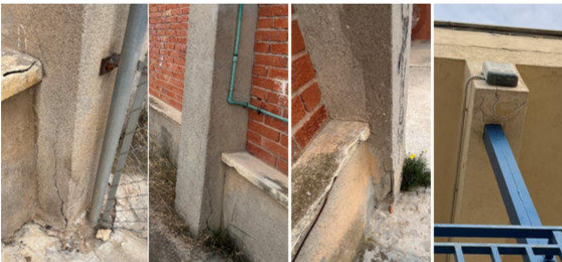
Imagen 15. Edificio C. Detalles daños detectados.
