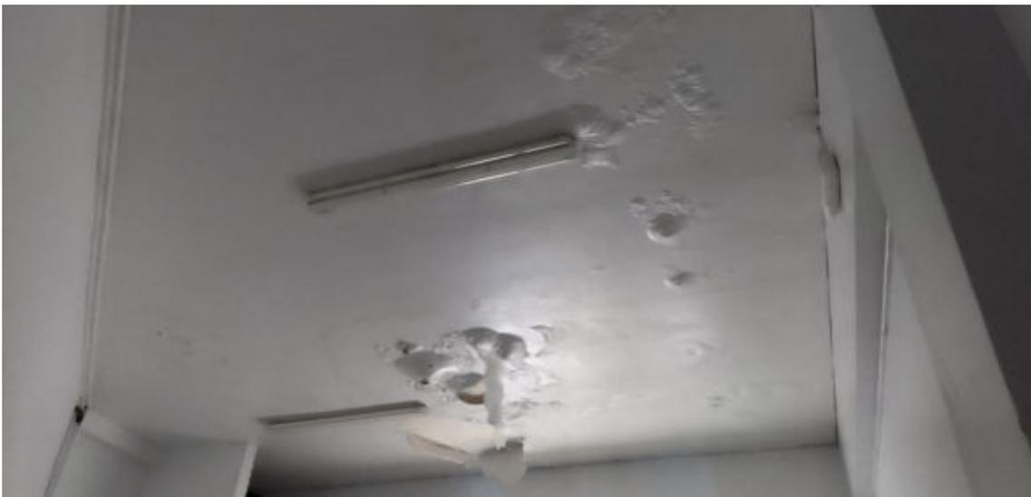
Imagen 12. Vista de daños por filtraciones en cubierta del Salón de Actos (almacén tras escenario).
