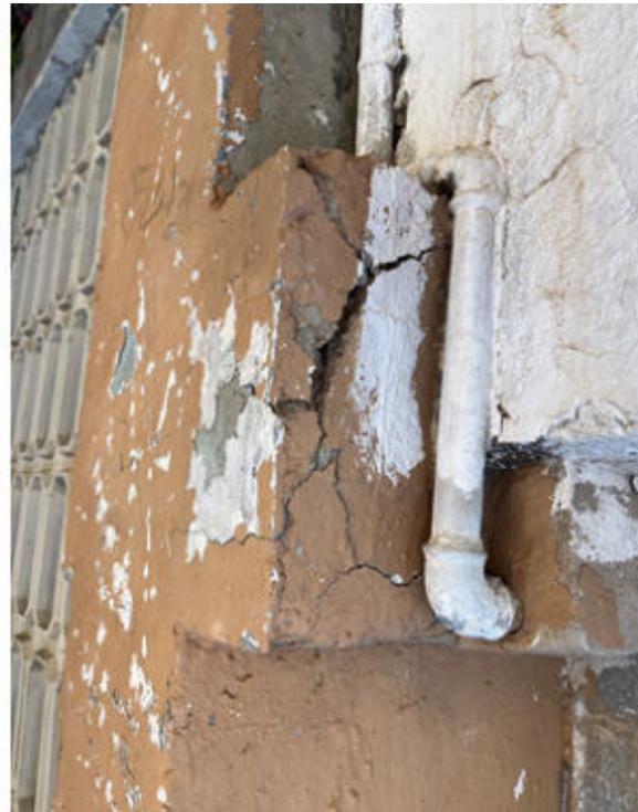
Imagen 17B. Daños viga forjado piso de planta baja de E1 (extremo NE).
