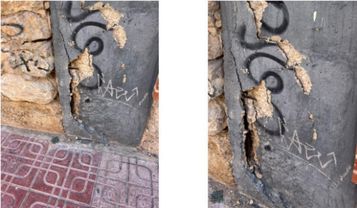
Imagen 17G. Pilares dañados en E2 con desprendimiento de material (fachada recayente a vial)
