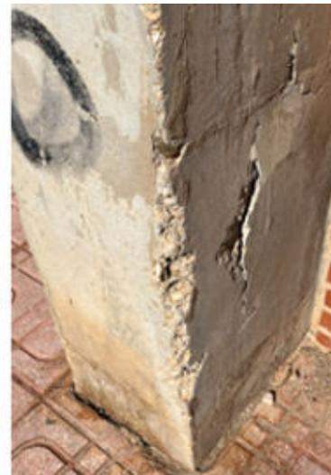
Imagen 17I. Daños en alero y pilares (interior y exterior) de E3
