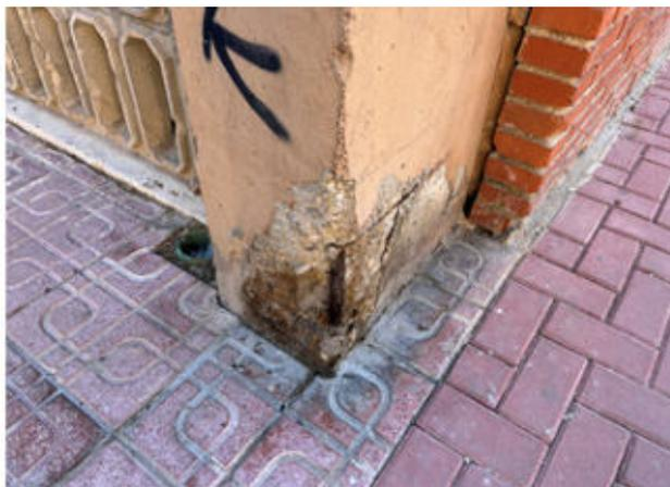
Imagen 17E. Daños en arranque y fuste de pilares
