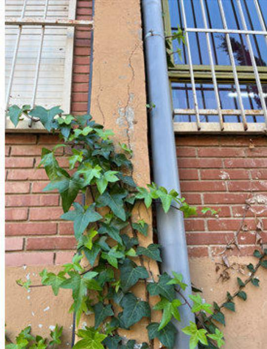
Imagen 17C. Daños en fuste de pilares
