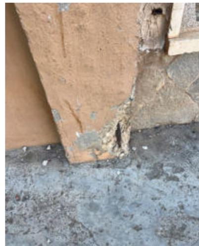
Imagen 17D. Daños en viga cimentación (arranque muro) y base de pilares
