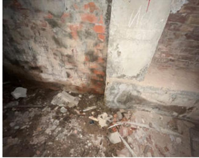
Imagen 17A. Daños en elementos estructurales en el espacio bajo rasante E1.
