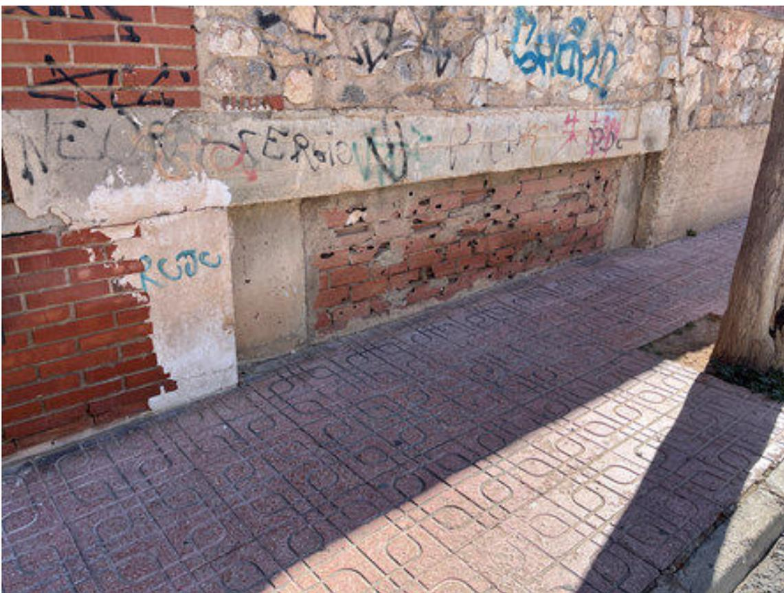
Imagen 17E. Pilar reparado y estado del cerramiento en vial Virgen de la Caridad con presencia de humedad
