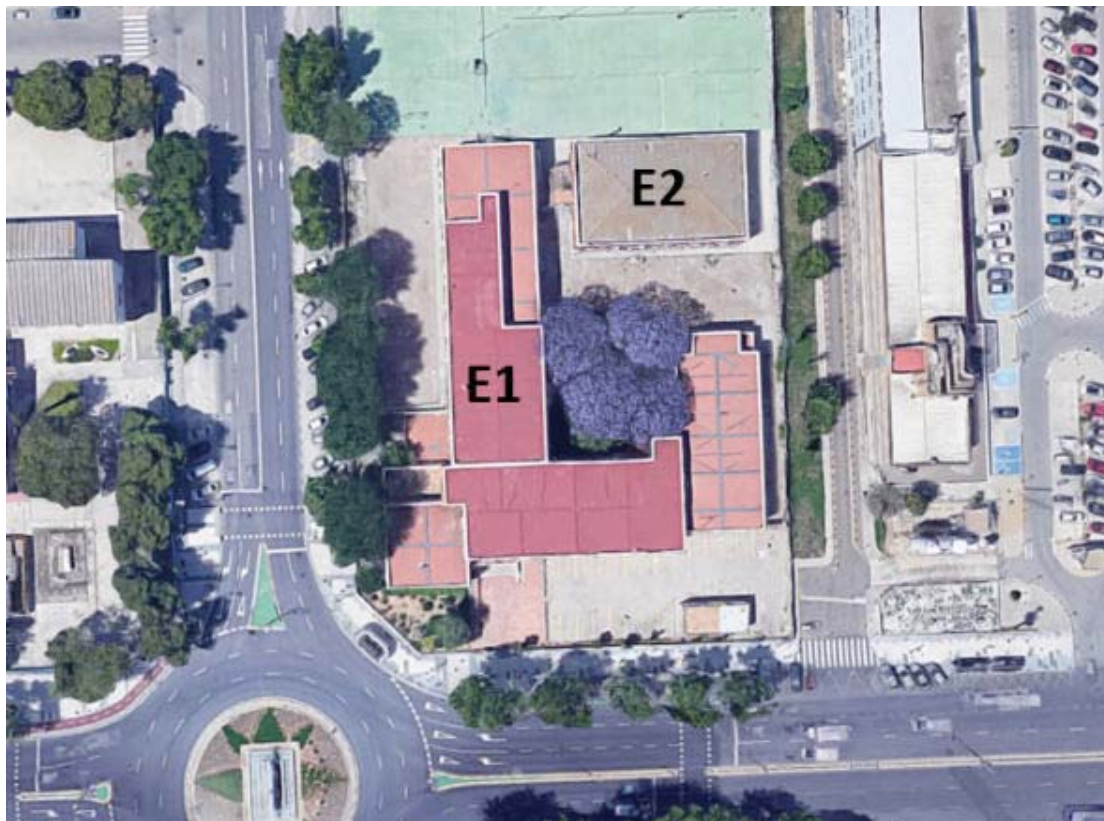
Imagen 1. Emplazamiento. Ortofoto parcela: Edificio 1 y Edificio 2.
