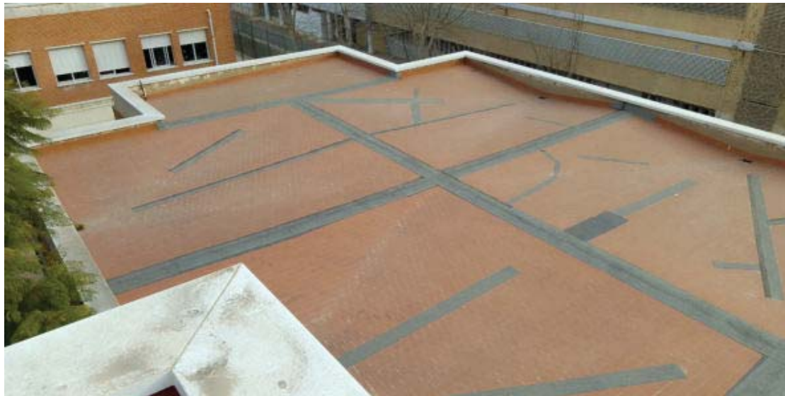
Imágenes 8. Edificio Principal. Vistas generales de las cubiertas
