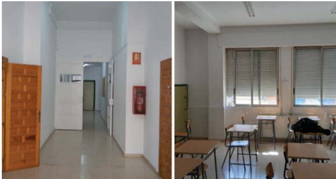
Imagen 15. Edificio Secundario. Vista interior de distribuidor de planta y de un aula
