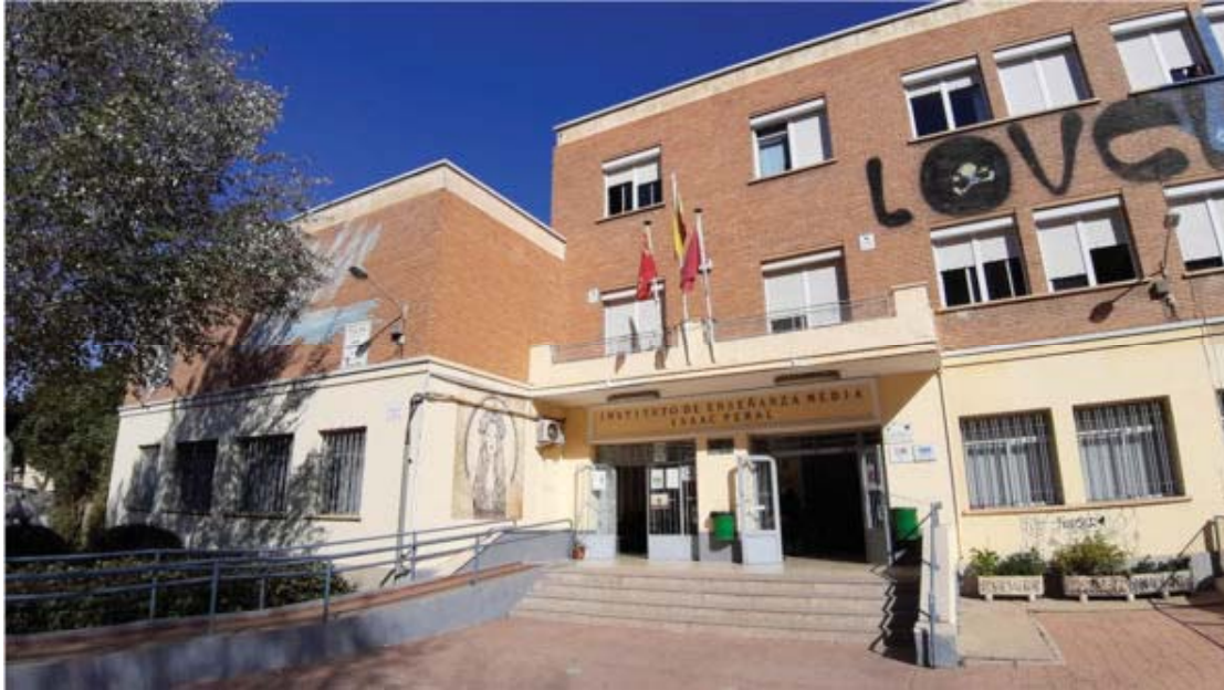
Imagen 2. Edificio Principal. Vista general fachada sur
