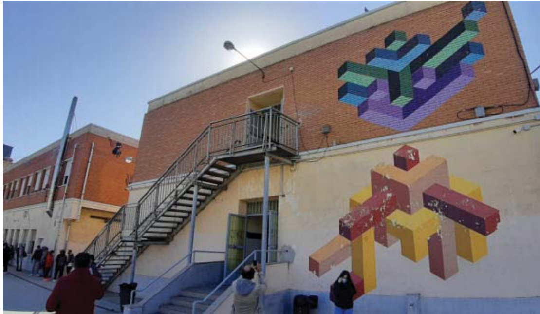
Imagen 9. Edificio Principal. Vistas general escalera exterior metálica
