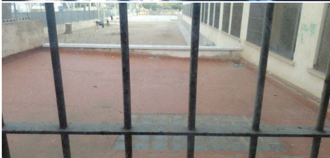
Imagen 5A y 5B. Edificio Principal. Vista general interior del gimnasio y vista terraza del almacén anexo
