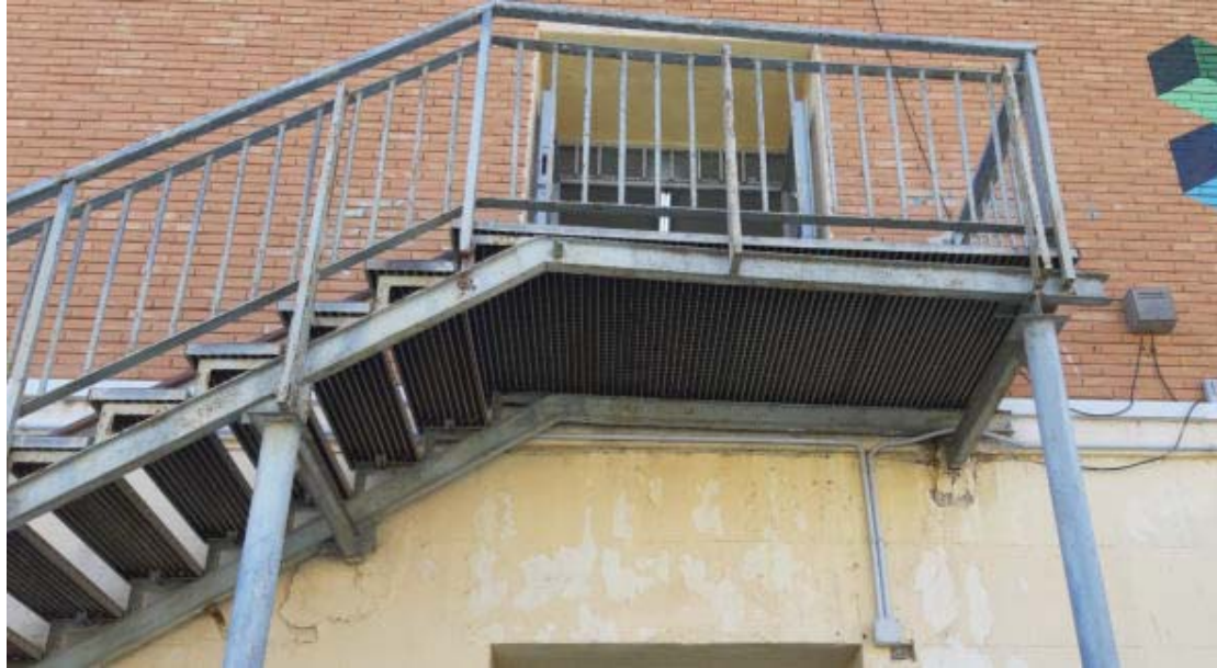
Imagen 11. Edificio Principal. Vistas escalera exterior metálica
