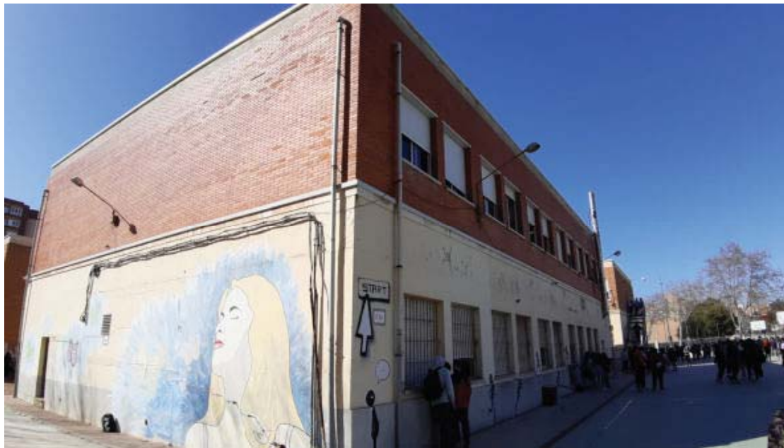
Imagen 12. Edificio Secundario. Vista fachada norte y este
