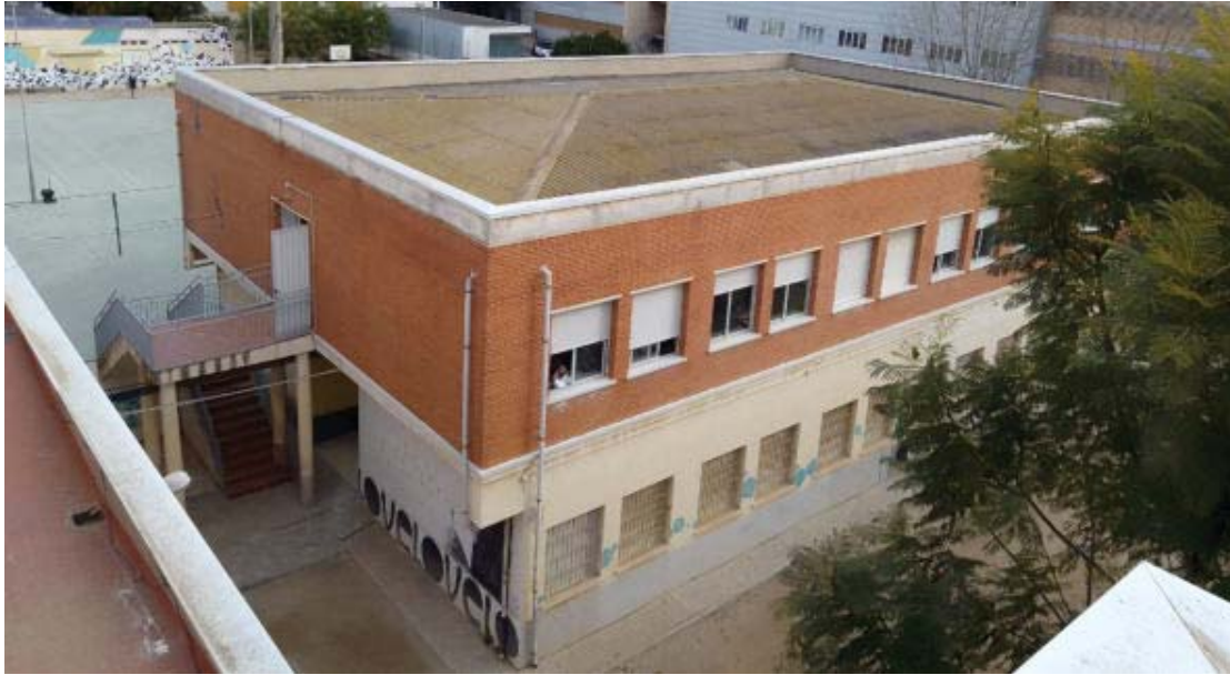
Imagen 13. Edificio Secundario. Vista general del inmueble y cubierta
