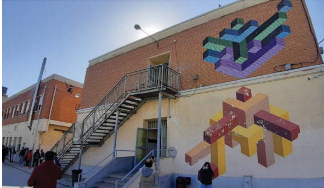
Imagen 9. Edificio Principal. Vistas general escalera exterior metálica
