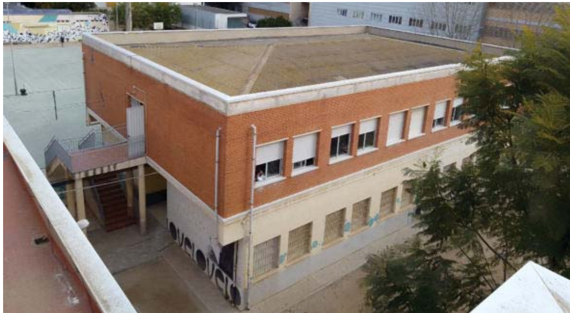
Imagen 16. Edificio Secundario. Vista general del inmueble y cubierta
