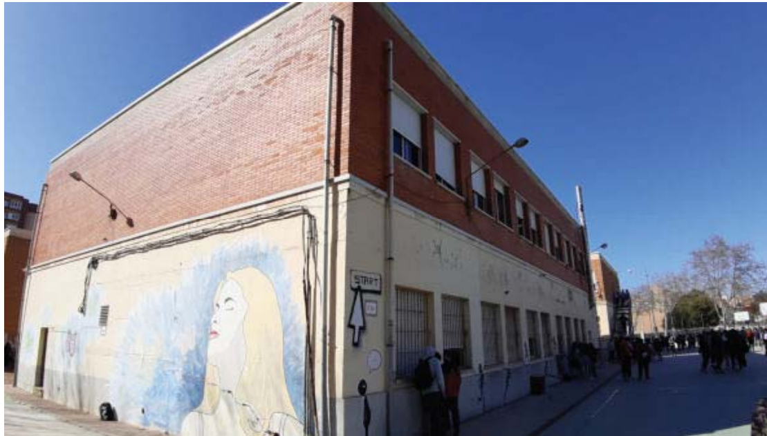
Imagen 12. Edificio Secundario. Vista fachada norte y este
