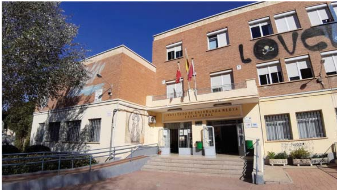
Imagen 2. Edificio Principal. Vista general fachada sur
