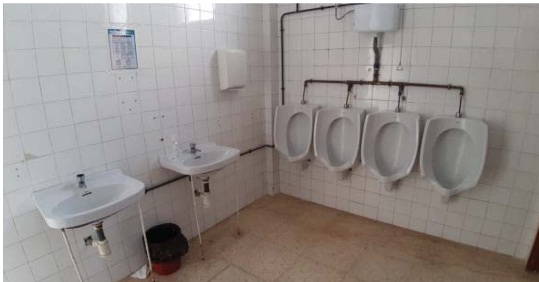
Imagen 9. Edificio 3. Anexo aseos
