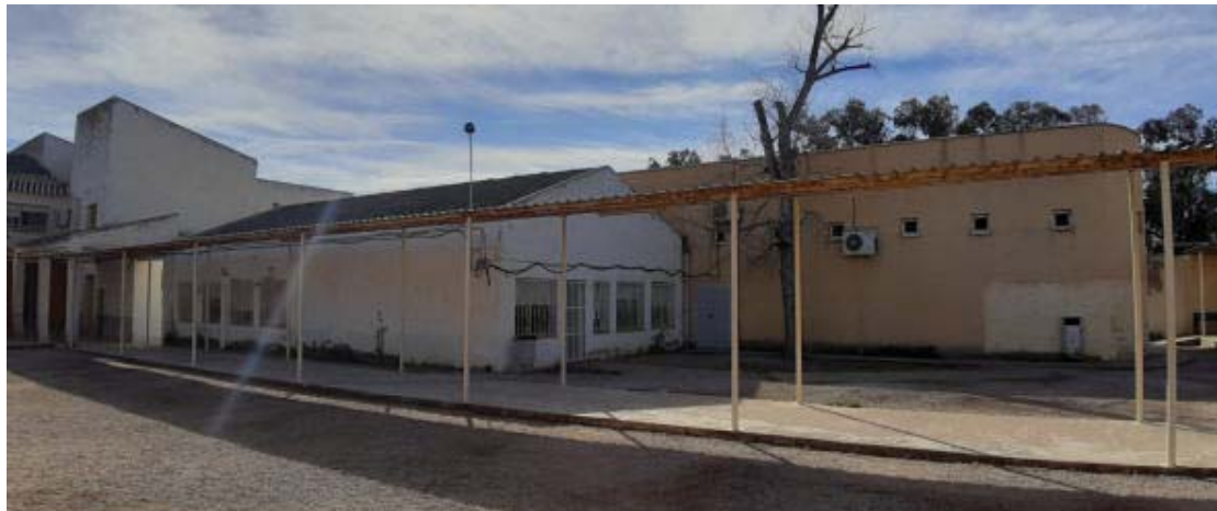
Imagen 7. Edificio 3. Vista general desde el noroeste
