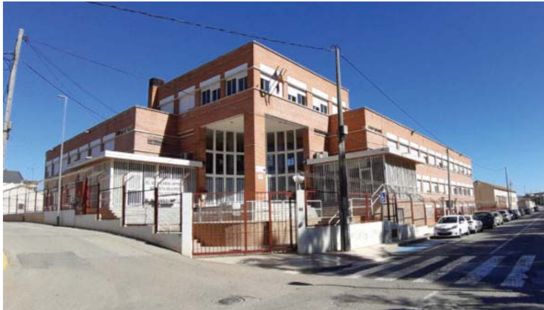
Imagen 2. Edificio 1. Vista general esquina: encuentro fachadas sur y oeste
