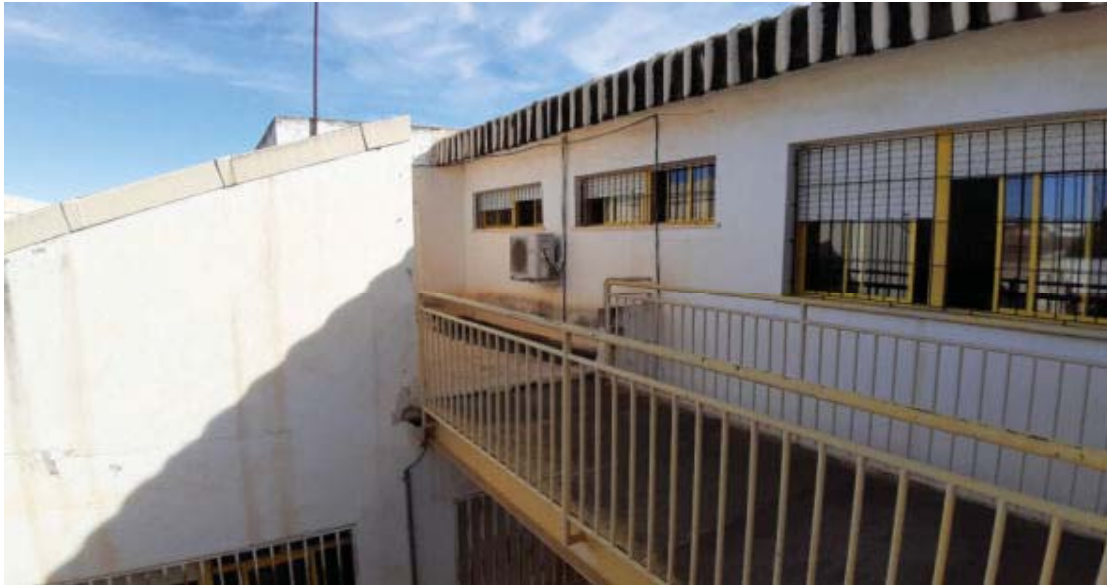
Imagen 17. Edificio 5. Vistas pasarela conexión E4 y E5.
