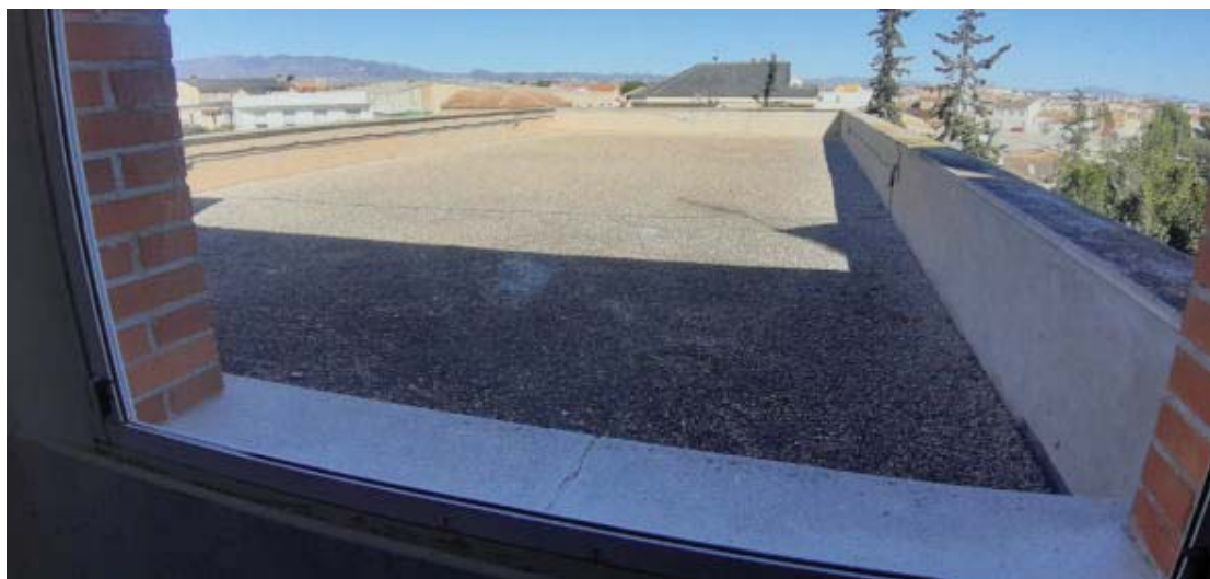
Imagen 6. Edificio 1. Vista general cubierta ala norte
