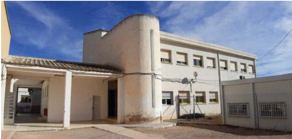
Imagen 10. Edificio 4. Vista general y anexo aseos
