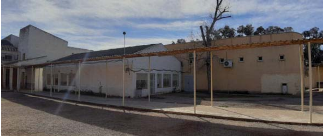
Imagen 7. Edificio 3. Vista general desde el noroeste
