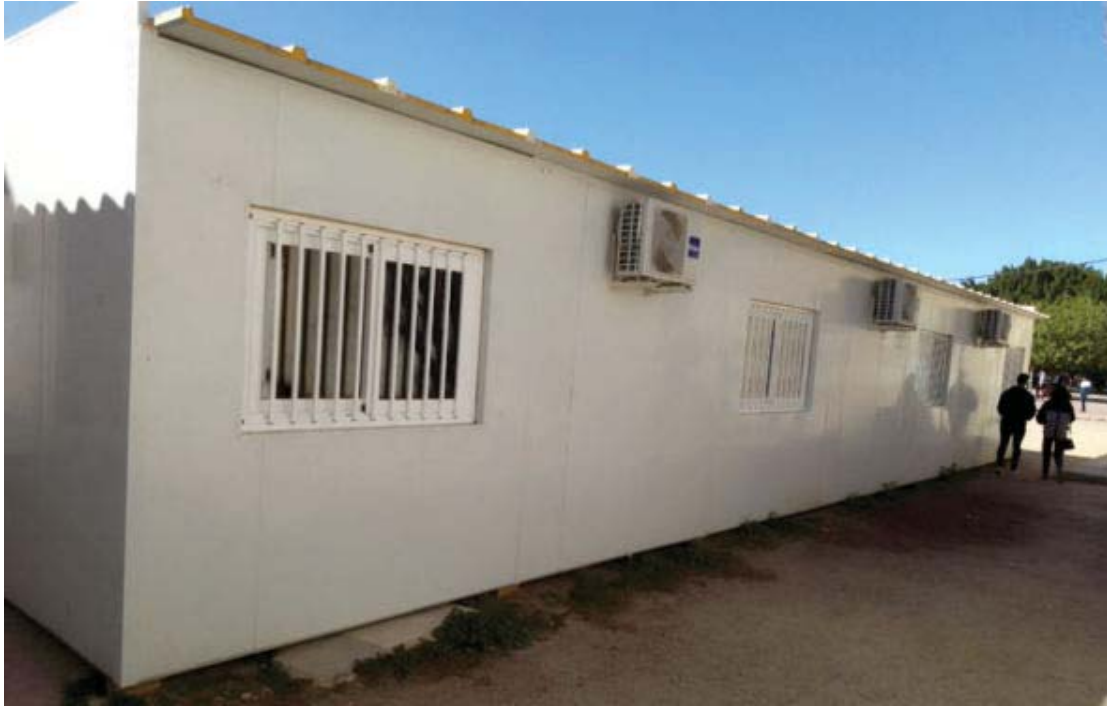
Imagen 22A y 22B. Módulos prefabricados existentes, actualmente, entre E3, E4 y E5. Fotografía realizada desde la fachada de acceso al inmueble E5.
