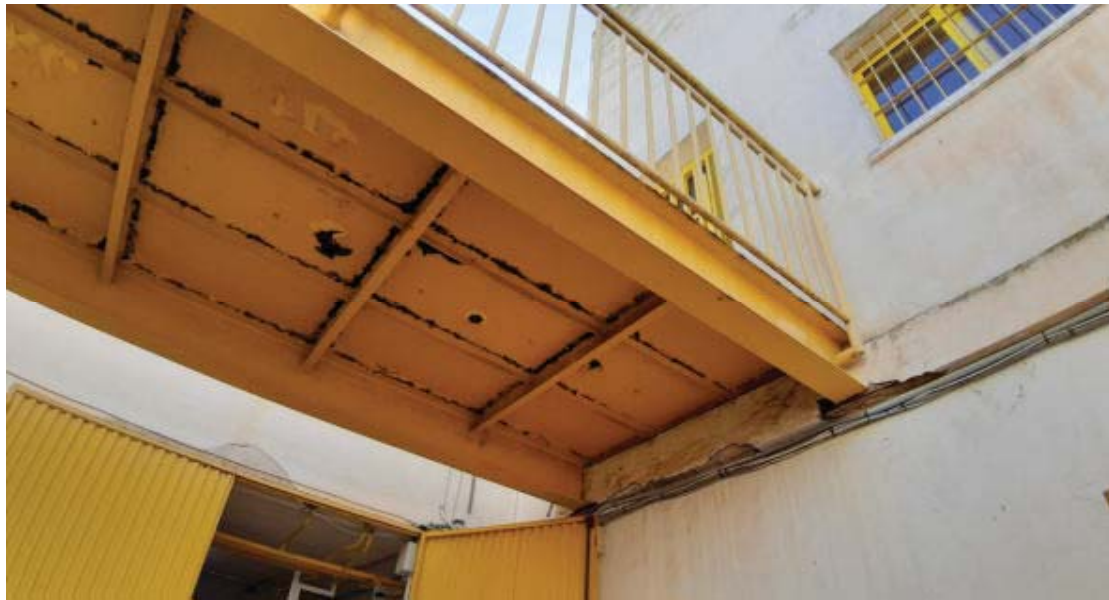
Imagen 16. Edificio 5. Vista pasarela conexión E4 y E5.
