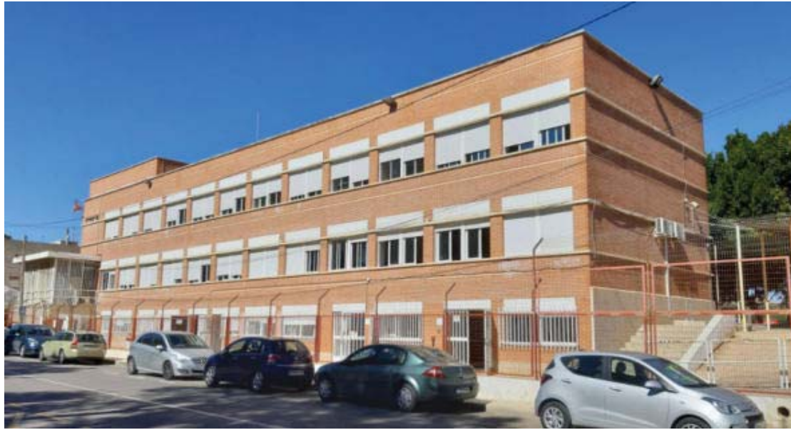
Imagen 3. Edificio E1. Vista general fachada sur: desnivel parcela y semisótano como planta baja
