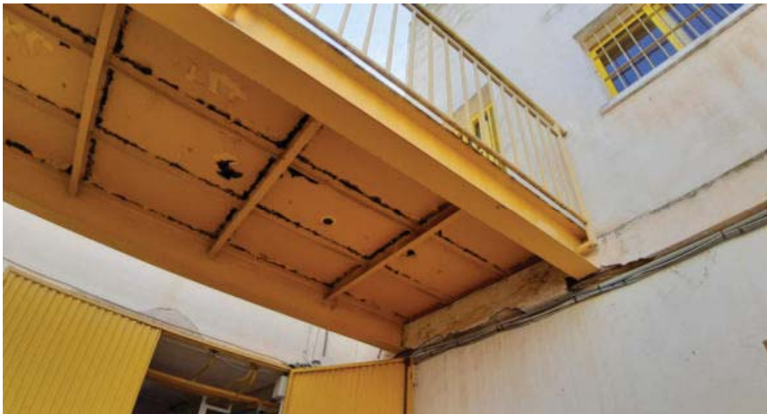
Imagen 16. Edificio 5. Vista pasarela conexión E4 y E5.
