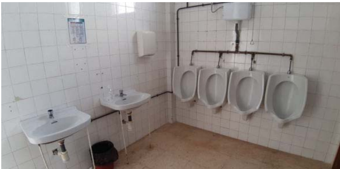
Imagen 9. Edificio 3. Anexo aseos
