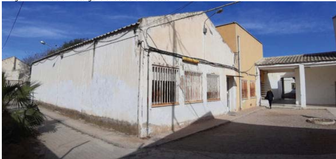
Imagen 8. Edificio 3. Vista general desde el sureste
