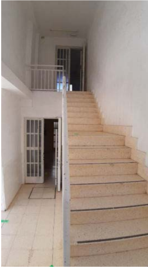
Imagen 13. Edificio 4. Vista escalera exterior y distribuidor interior
