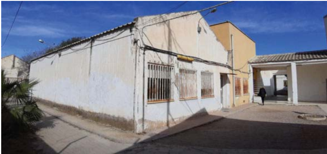
Imagen 8. Edificio 3. Vista general desde el sureste
