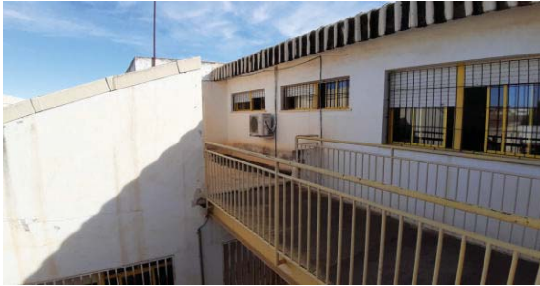
Imagen 17. Edificio 5. Vistas pasarela conexión E4 y E5.
