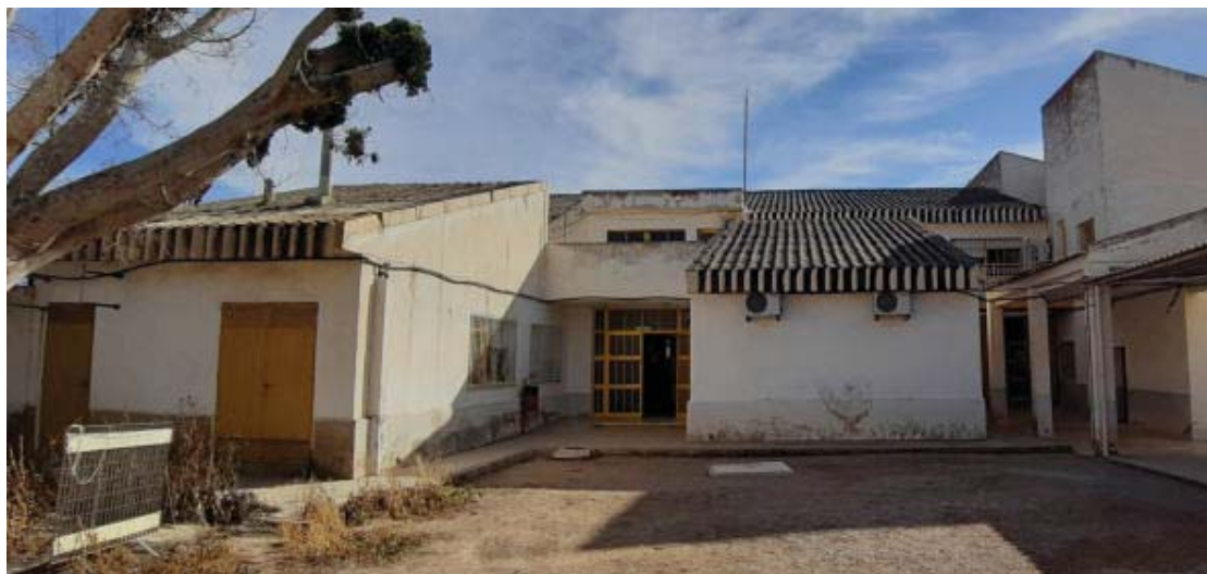
Imagen 14. Edificio 5. Vista general exterior del acceso
