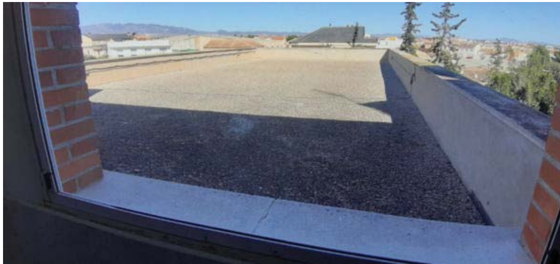
Imagen 6. Edificio 1. Vista general cubierta ala norte
