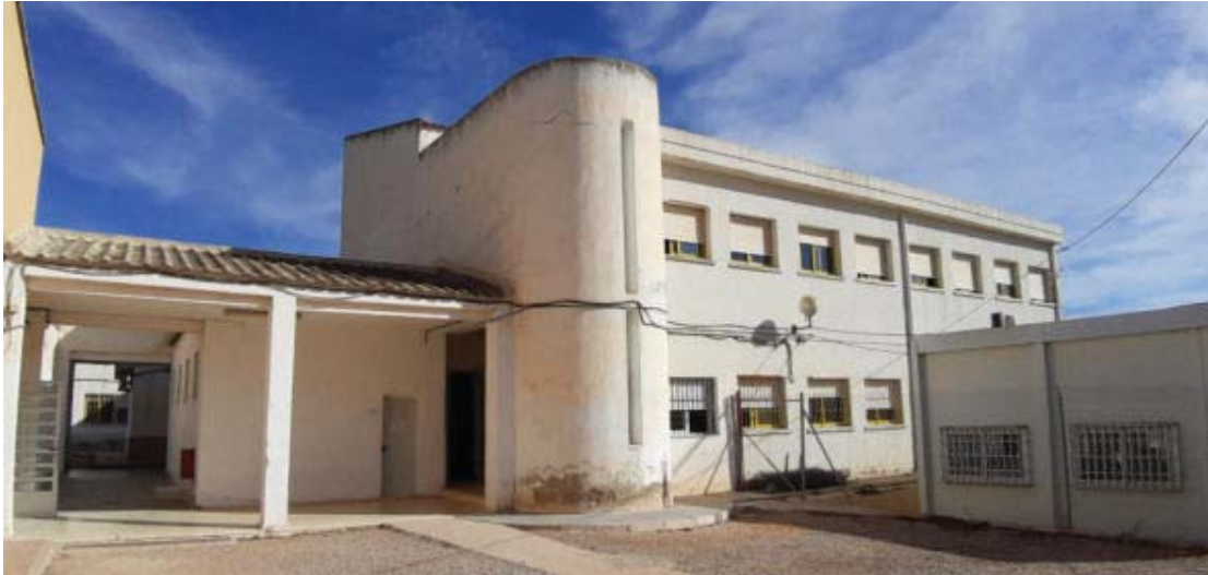
Imagen 10. Edificio 4. Vista general y anexo aseos
