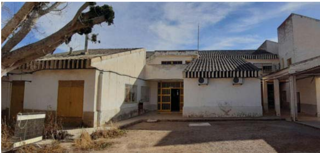
Imagen 14. Edificio 5. Vista general exterior del acceso
