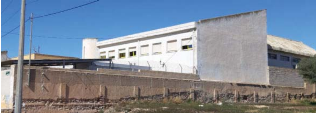
Imagen 11. Edificio 4. Vista general desde la Av. Mar Menor
