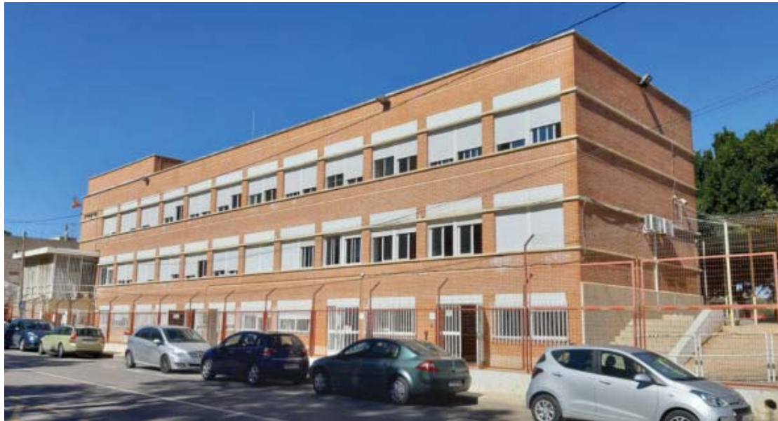
Imagen 3. Edificio E1. Vista general fachada sur: desnivel parcela y semisótano como planta baja
