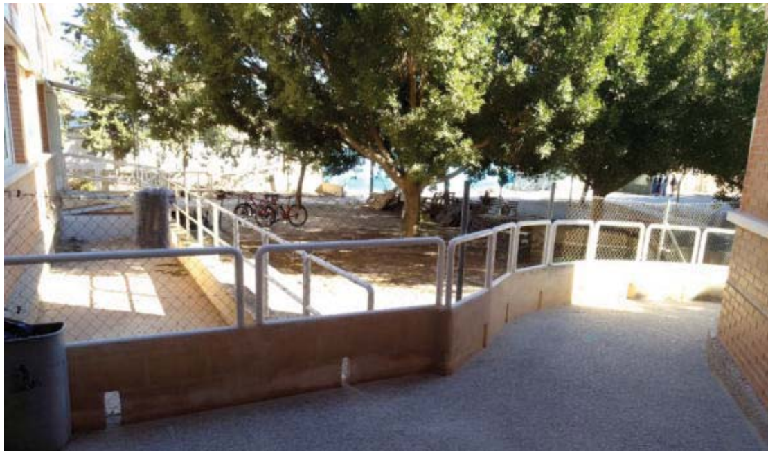
Imagen 4. Edificio E1. Vista salida a patio desde vestíbulo (rampa fachada norte) y foso iluminación semisótano
