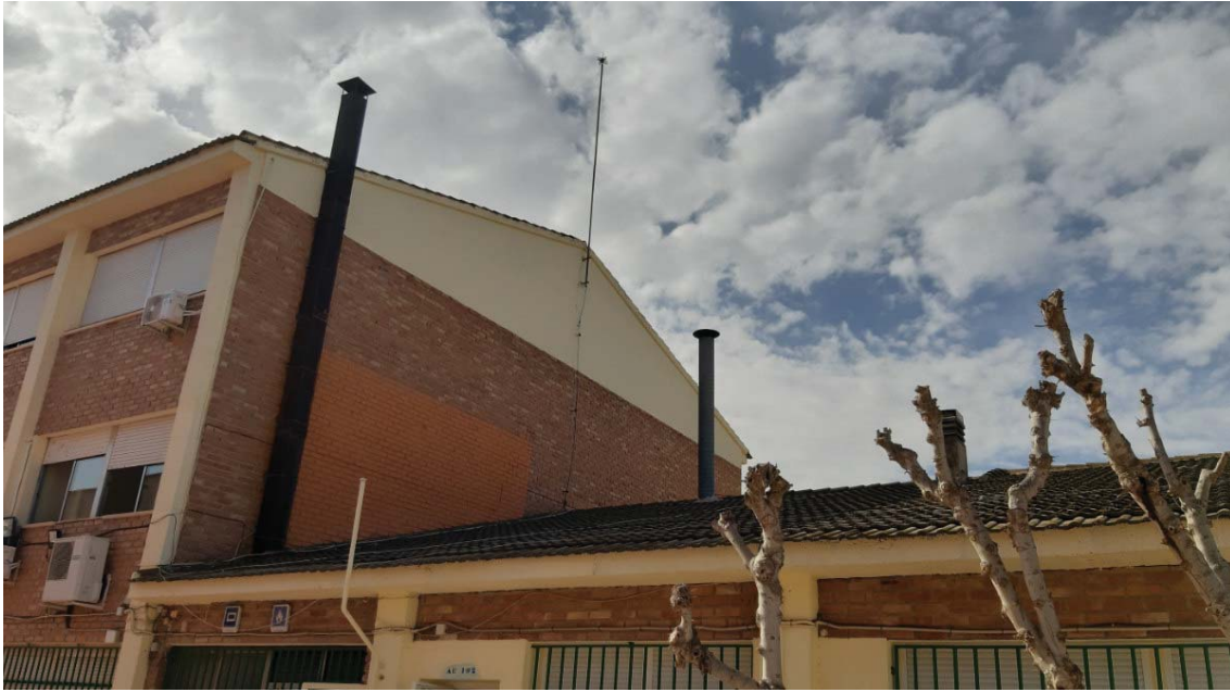
Imagen 4. Edificio 1. Vista fachada noreste
