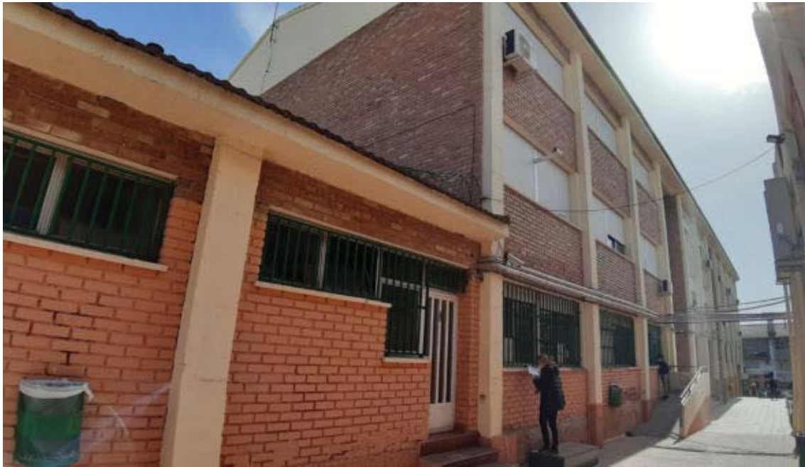
Imagen 2. Edificio 1. Vista fachada suroeste
