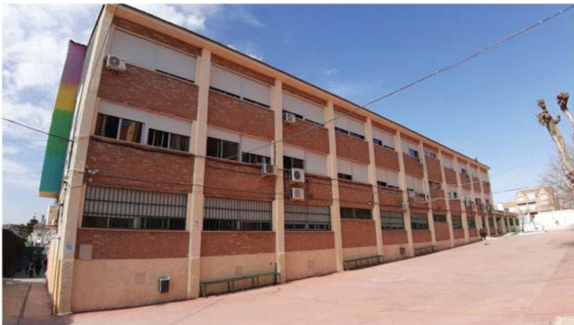
Imagen 3. Edificio 1. Vista fachada noreste
