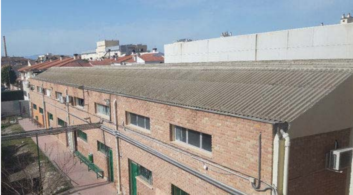
Imagen 10. Edificio 3. Vista general fachada sureste
