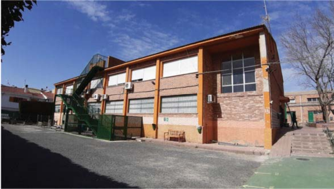
Imagen 6. Edificio 2. Vista general fachada sureste
