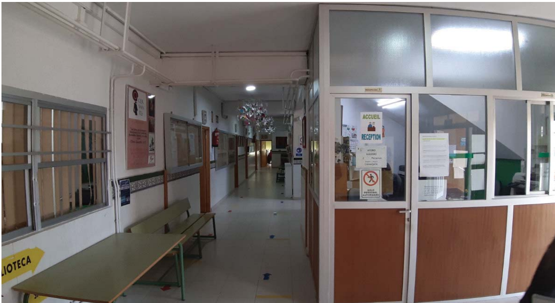
Imagen 5. Edificio 1. Vista interior vestíbulo
