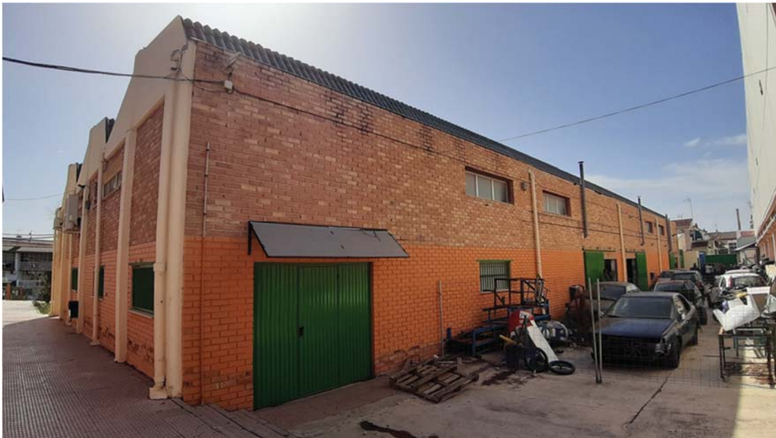
Imagen 9. Edificio 3. Vista general fachada noroeste
