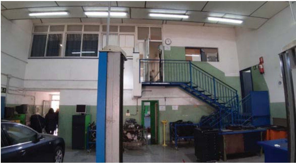
Imagen 11. Edificio 3. Vista interior taller
