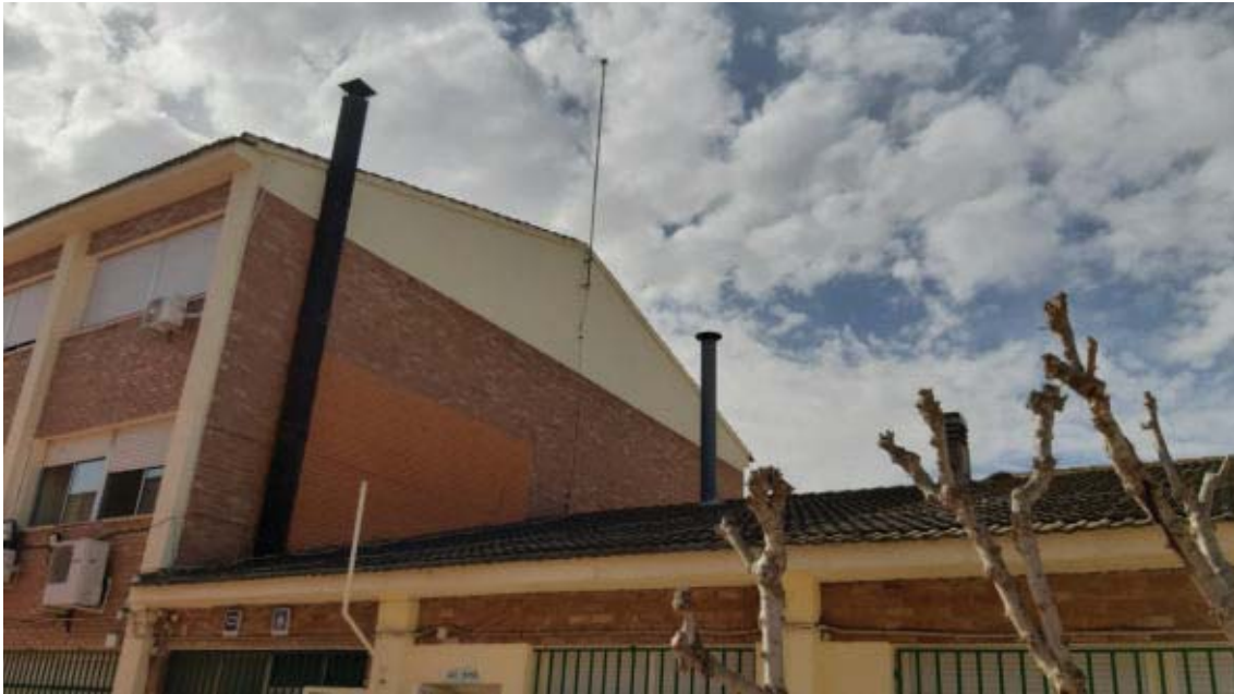
Imagen 4. Edificio 1. Vista fachada noreste
