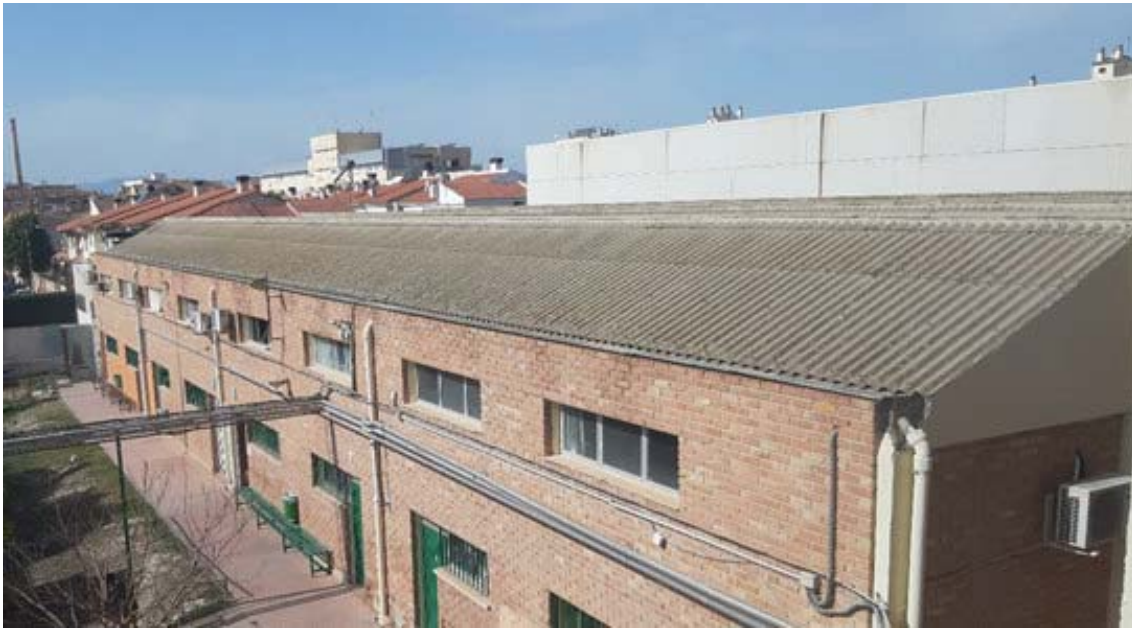
Imagen 10. Edificio 3. Vista general fachada sureste
