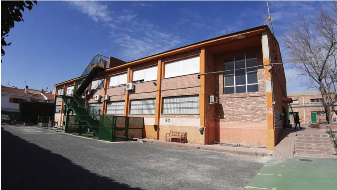
Imagen 6. Edificio 2. Vista general fachada sureste
