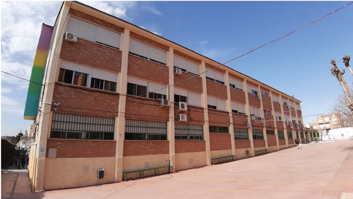
Imagen 3. Edificio 1. Vista fachada noreste
