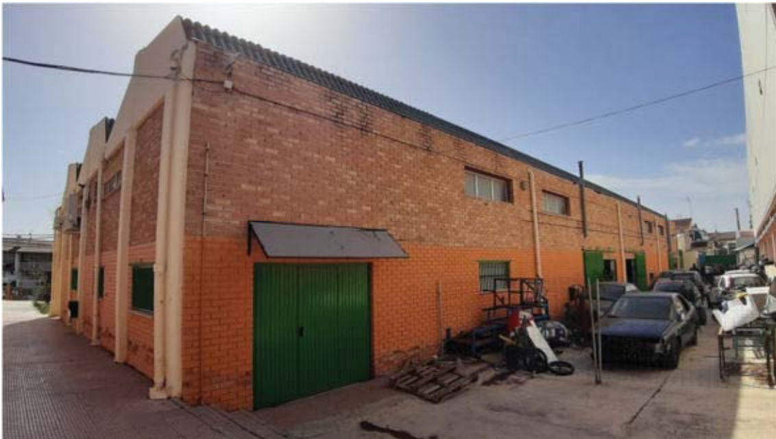
Imagen 9, Edificio 3. Vista general fachada noroeste
