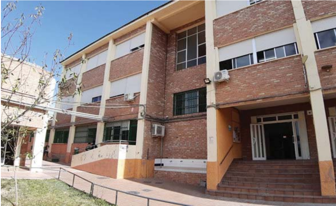
Imagen 2. Edificio 1. Vista fachada suroeste
