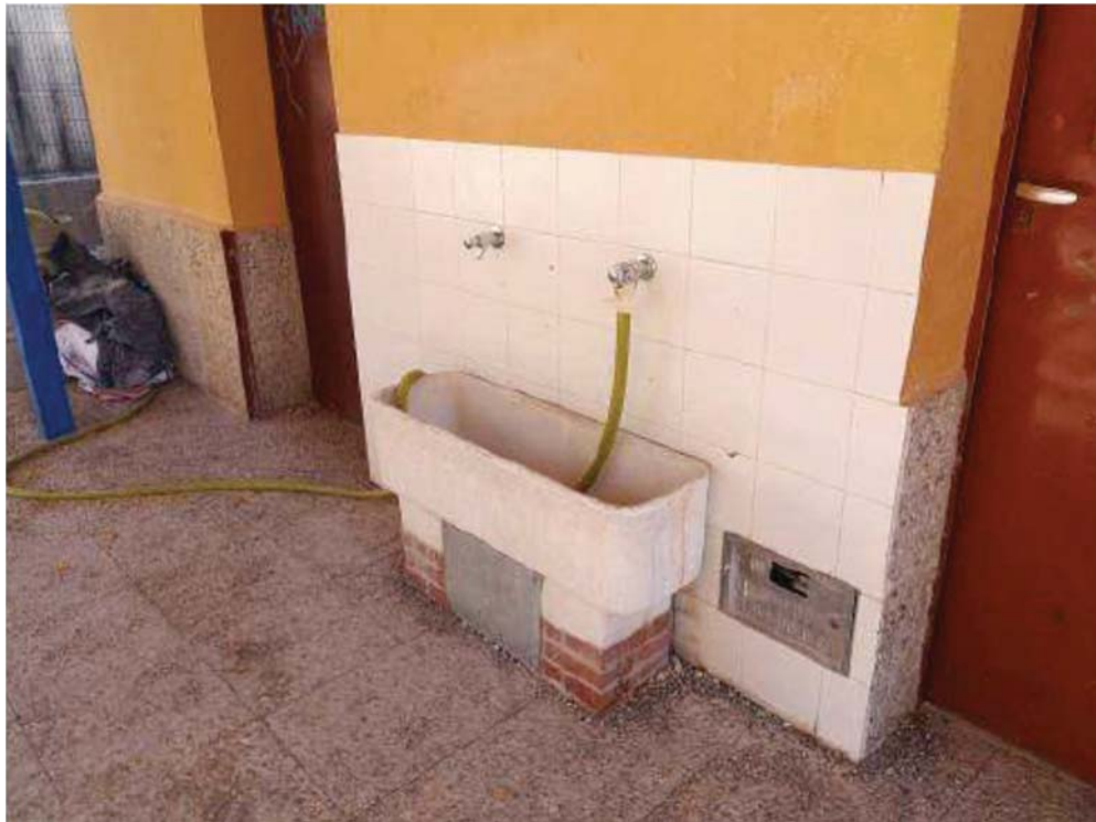
ESTADO ACTUAL DE LA FUENTE
