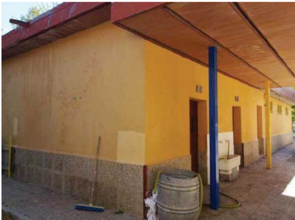
VISTA EXTERIOR DE LOS ASEOS A REHABILITAR
