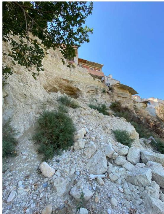
Fig.01. Detalle de los desprendimientos que han tenido lugar recientemente y el lavado de la zona de apoyo de las cimentaciones de las viviendas existentes.
