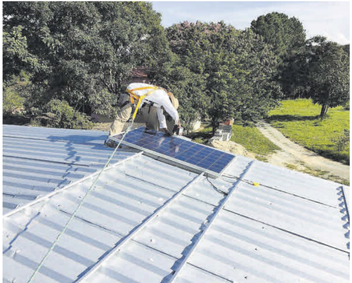
Instalación de una planta fotovoltaica en una finca.
