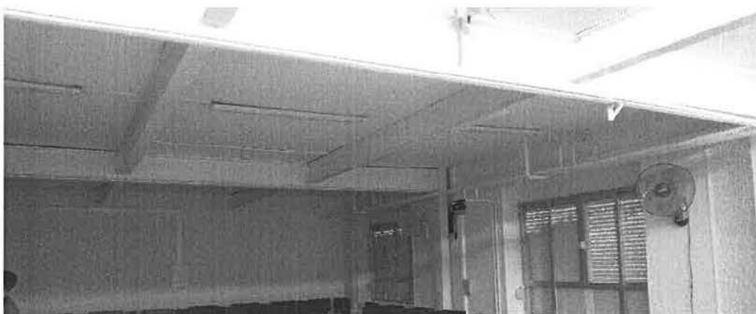
Imagen: Módulo A, entramado metálico de vigas del forjado unidireccional.
