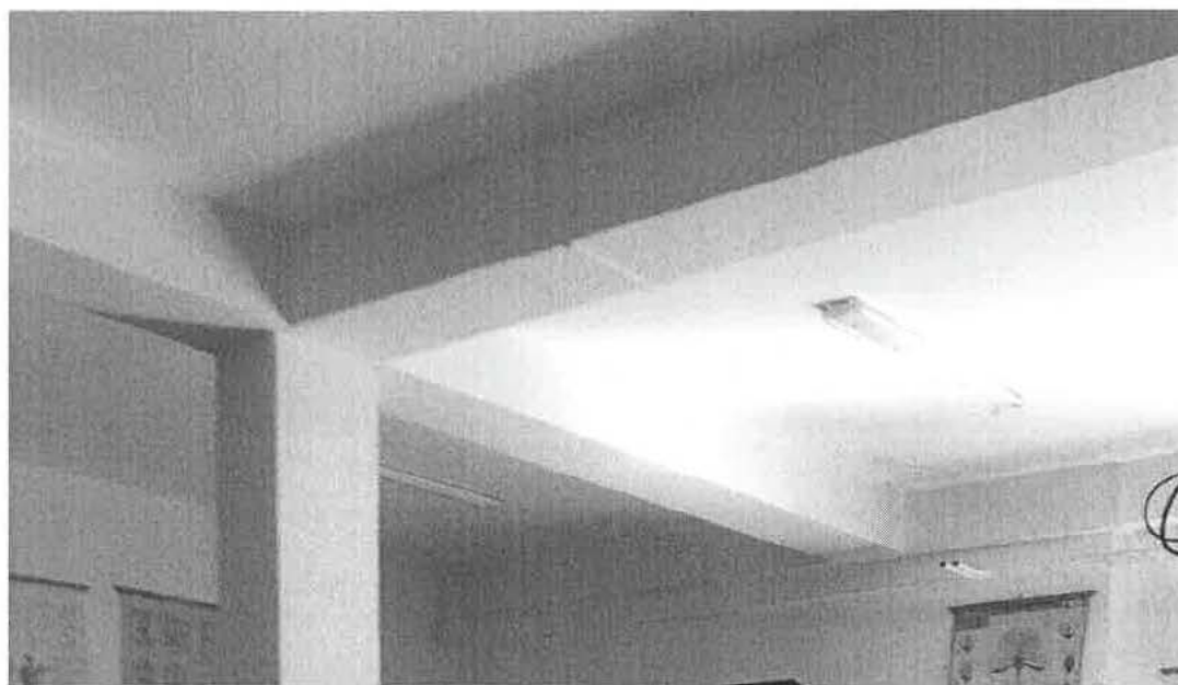
Imagen: Módulo B, vigas de hormigón armado descolgadas.
