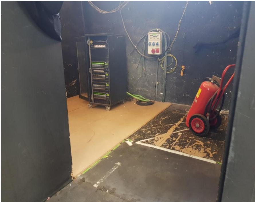
Imágenes de las zonas del escenario donde se produjo la rotura del tablero y el hundimiento puntual. En la fotografía se observa la colocación de paneles provisionales de contrachapado.
