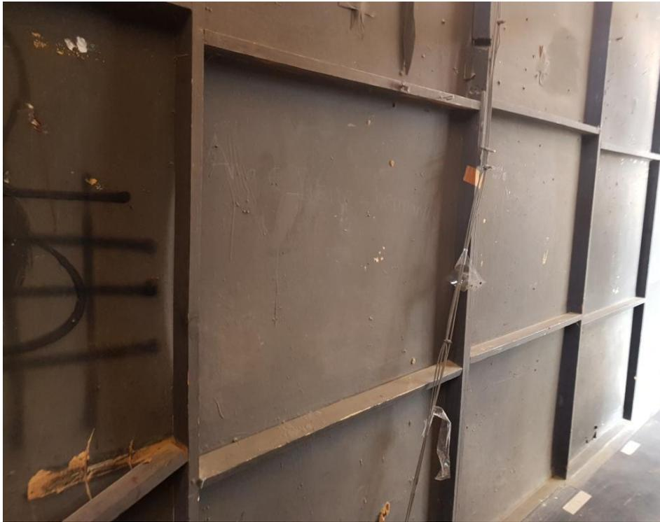
Imágenes del estado del fondo del escenario por la parte trasera: falta de estabilidad, alabeos, rotura de elementos de rigidización del bastidor, descuelgue de tirantes de sujeción, etc.
