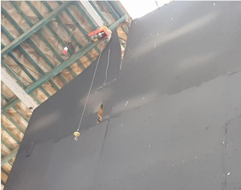
Parte superior del fondo del escenario donde se observa que se ha despegado uno de los tableros del panel, y la rotura de otro panel. Falta de planeidad y mal estado de la superficie del tablero.
