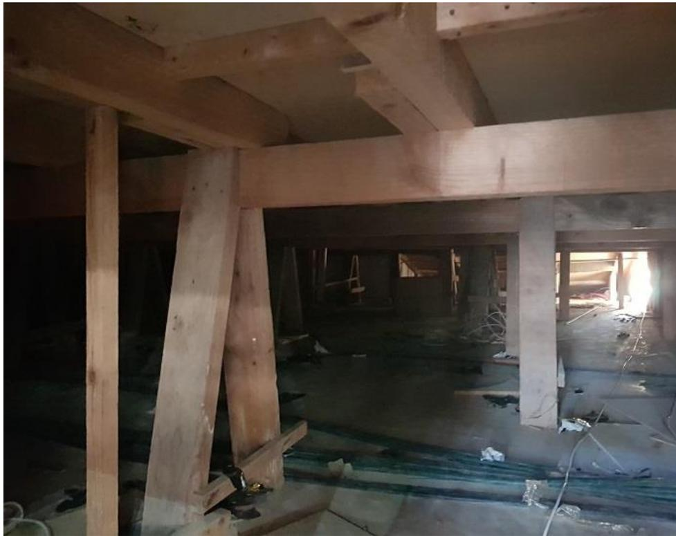
Imagen de la estructura de madera que soporta el escenario.
