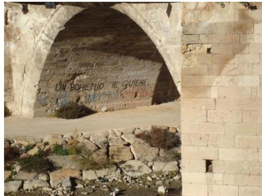
*Mal de la piedra en numerosas partes del puente, desprendimiento de sillares y pintadas*
