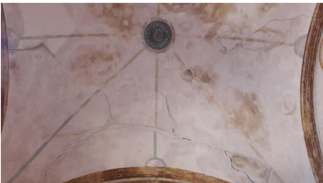
Grietas en la cúpula del Sepulcro y desplazamiento hacia los arcos
