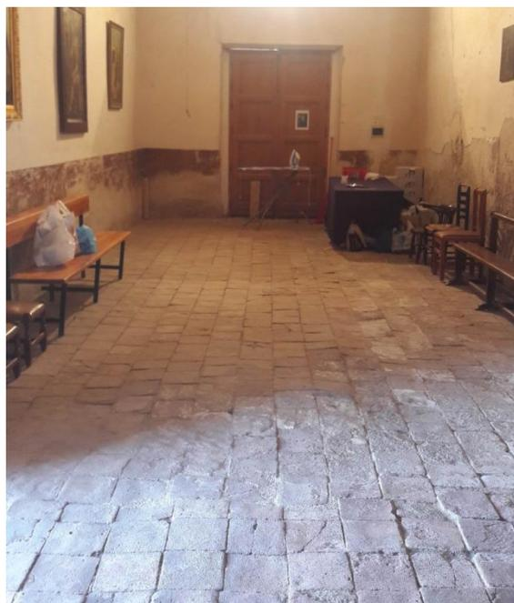
Pavimento interior del Sepulcro desnivelado y deteriorado
