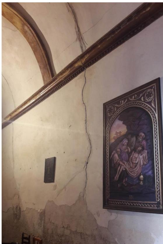
Continuidad de las grietas de la bóveda en los muros laterales
