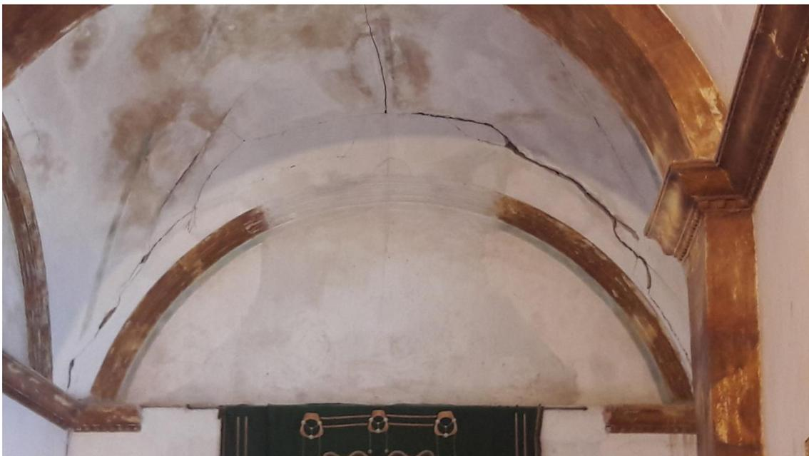
Grietas y fisuras en la cúpula del Sepulcro con continuidad hacia las esquinas de muros
