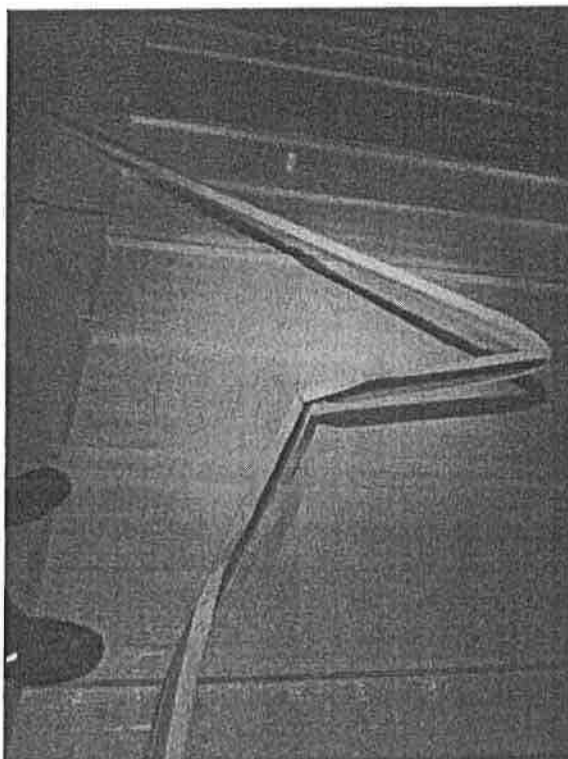
Desprendimiento piezas de cubierta
