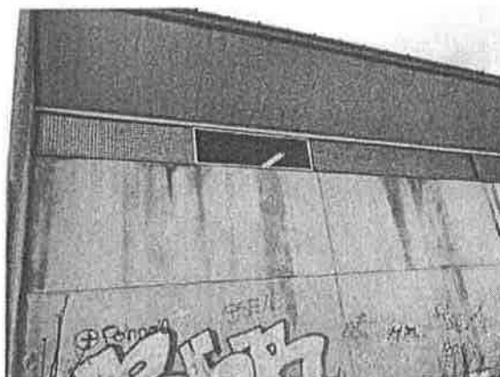
Desprendimiento de ventanas gimnasio
