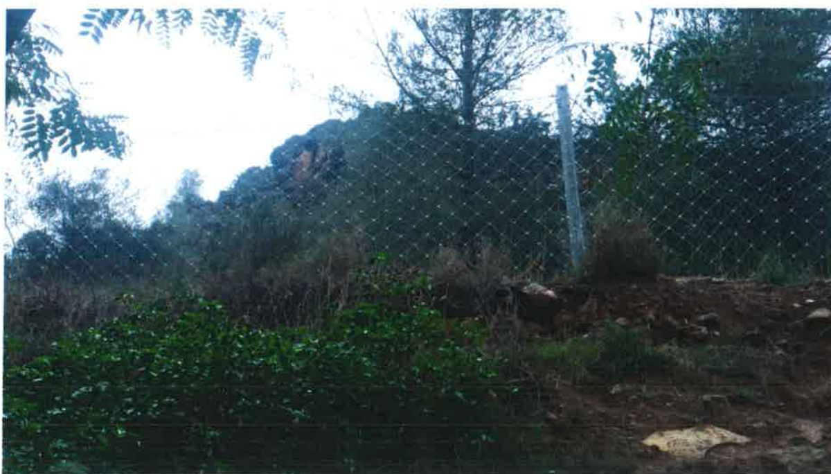
Tramo de barrera dinámica existente, vista inferior
