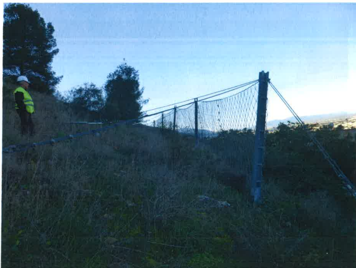
Tramo de barrera dinámica existente en la parte oeste de la ladera
