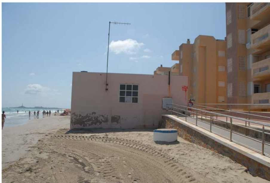
Fig. 17. Caseta de emisario en DPMT. EBAR los Méxicos. (Fuente: Elaboración propia).
