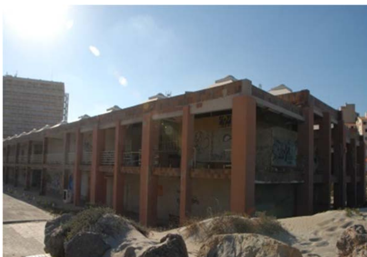
Fig. 19. Galerías Comerciales abandonadas en La Manga frente Hotel Dobleamar. (Fuente: Elaboración propia).
