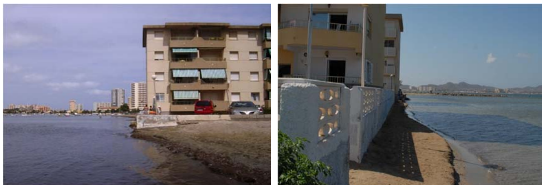
Fig. 16. Edificaciones en Dominio Público. Problemas de borde. (Fuente: Elaboración propia).
